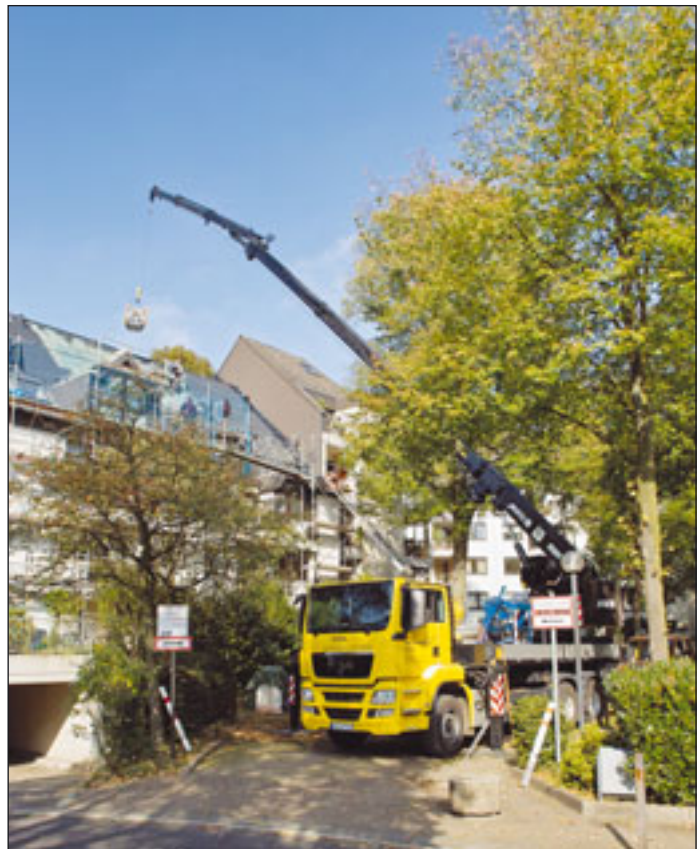
MKG-Kran im Einsatz
